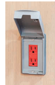
非常用コンセント(参考写真)
