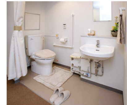
洗面ユニット
