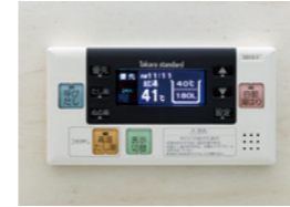
浴室給湯リモコン
