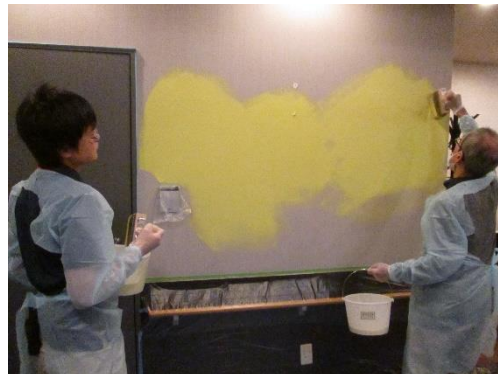
スタッフ自ら仕上げを施す様子
