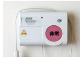
緊急呼出装置
